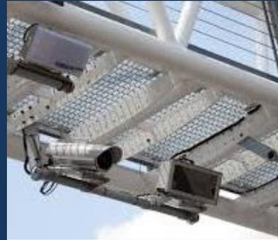
Los Sensores en diferentes intersecciones le permiten al sistema monitorear en tiempo real el tráfico de forma que la central optimiza los ciclos de los semáforos
